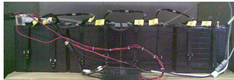
Sistema d'accumulo modulare 48V-100Ah, completo di BMS
