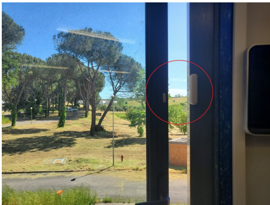
Figura 69. Il sensore di apertura e chiusura finestra con collegamento wireless di tipo Z-Wave
