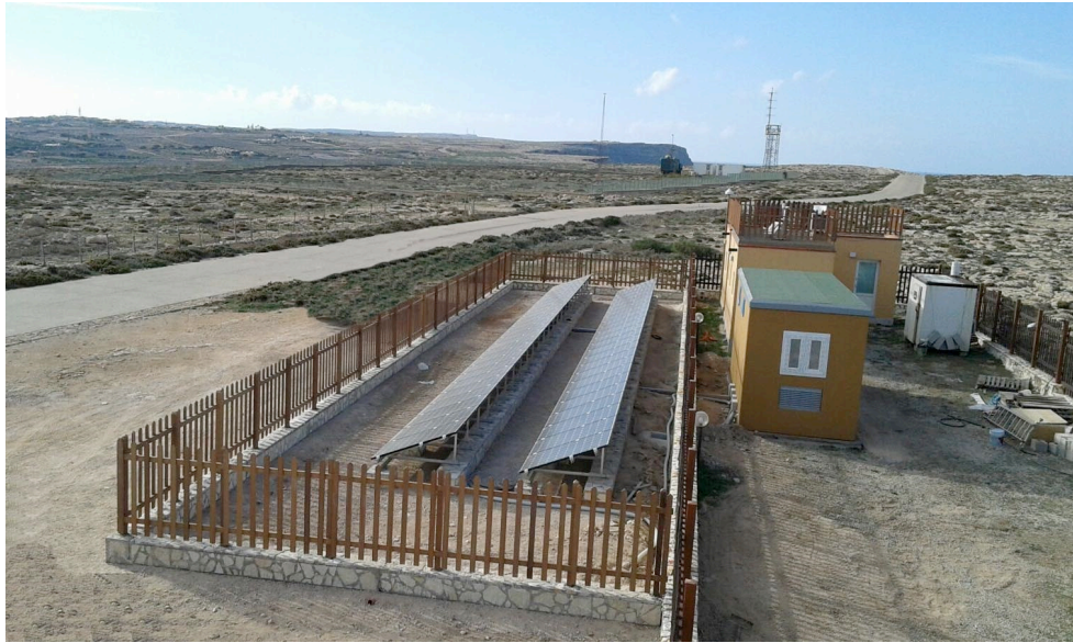
Figura 38. L'impianto fotovoltaico (14,2 kWp) con accumulo di Lampedusa
