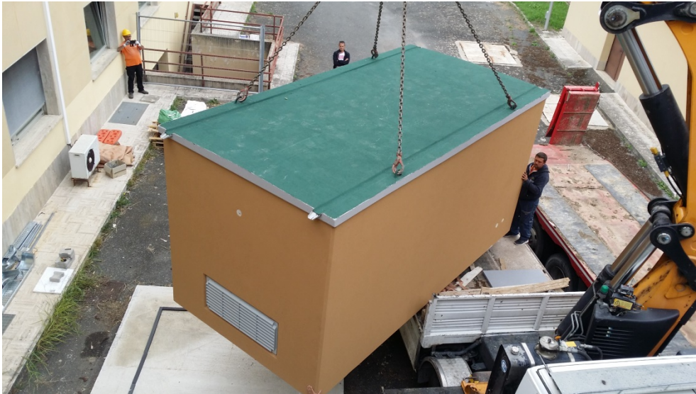
Figura 35. Il locale cabina impianto F40 in fase di posa in opera
