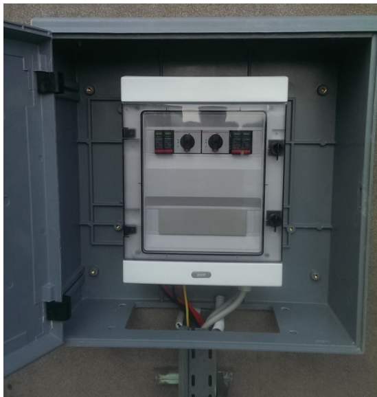
Figura 21. I Quadri di campo QCAM1 e QCAM2
