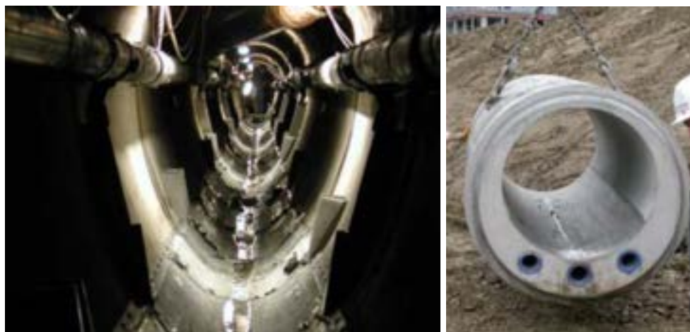
Figura 2-8: Scambiatore di calore in una rete fognaria (sinistra) ed elemento fognario con scambiatore di calore integrato (destra)
