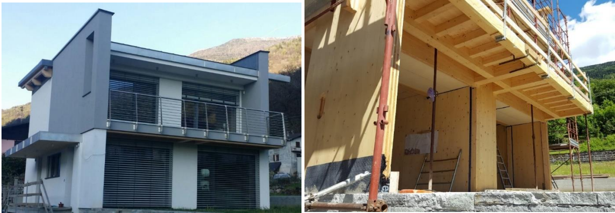
Figura 2-1 Caso studio 1: vista d'insieme e dettagli della fase di costruzione
