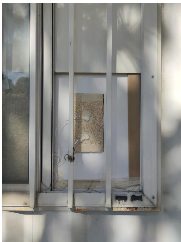
Figura 20: cornice isolata montata in parete.
