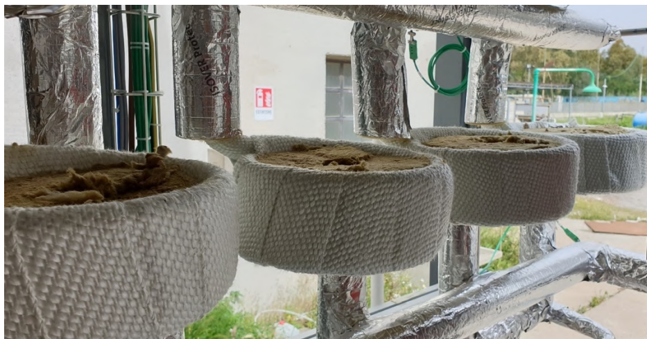
Figura 5.21. Realizzazione della coibentazione dello scambiatore di calore con il rivestimento iniziale di fibra di vetro.
