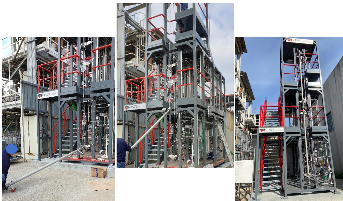
Figura 5.15. Posizionamento e installazione finale del reattore monotubolare.
