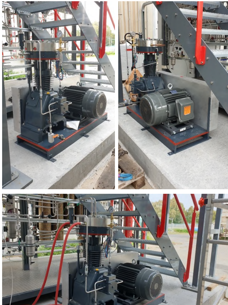
Figura 5.23. Posizionamento finale (in alto) e collegamento del compressore alla sezione di ricircolo dell'impianto (in basso).
