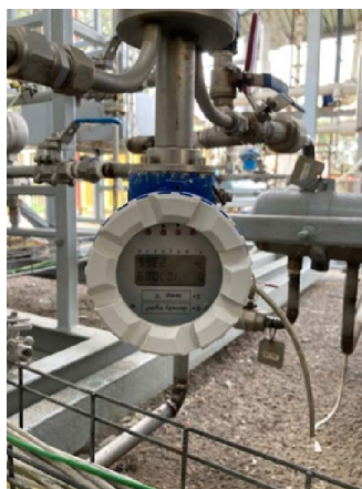
Figura 2.22. Densimetro installato sulla linea del solvente esausto.
