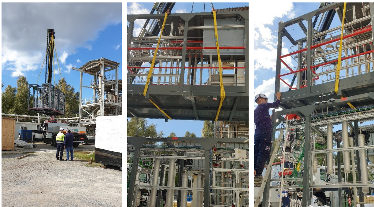
Figura 5.13. Movimentazione (sinistra), posizionamento (centro) e fissaggio (destra) delle diverse strutture modulari.
