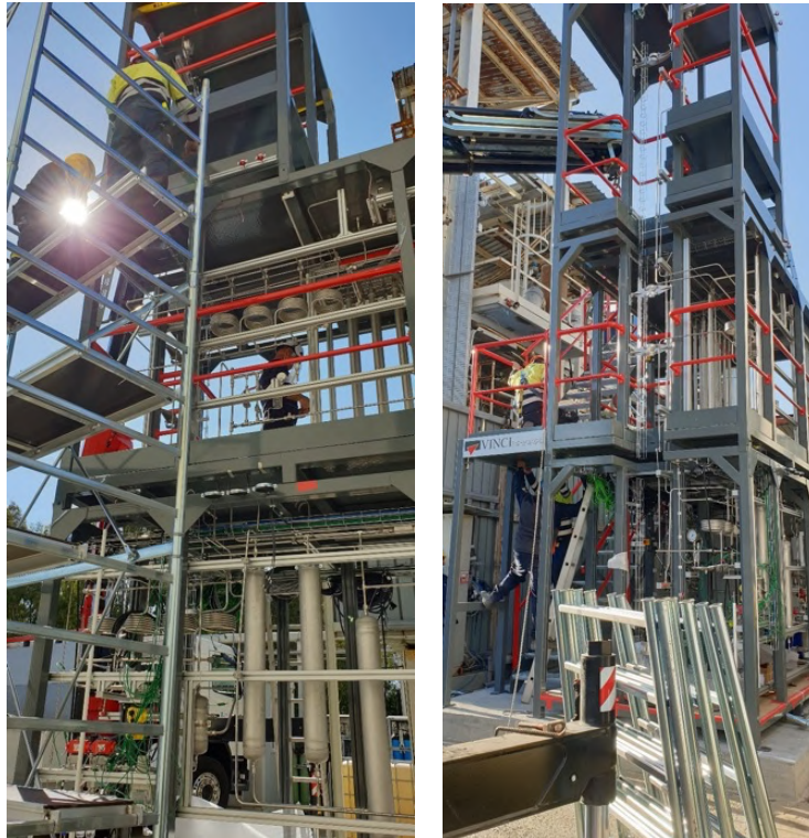
Figura 5.14. Esecuzione delle diverse interconnessioni meccaniche ed elettriche dei singoli moduli.
