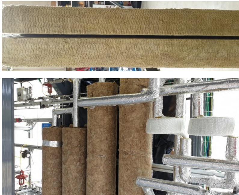
Figura 5.19. Lana di roccia pre-formatata impiegata come primo rivestimento termico per tutti i reattori e i separatori dell'olio (in alto). Messa in opera del primo strato di rivestimento termico sui quattro separatori dell'olio (in basso).
