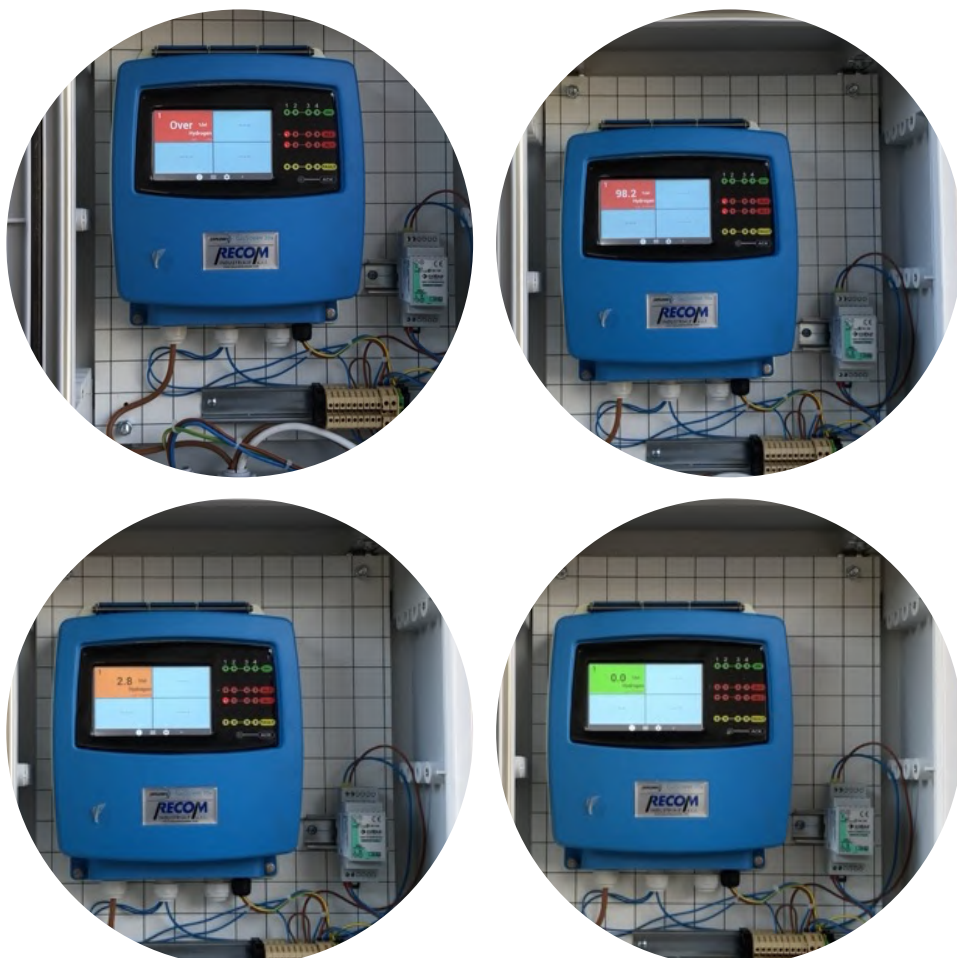
Figura 5.34. Centrale di rilevazione della concentrazione di idrogeno (fasi del collaudo).
