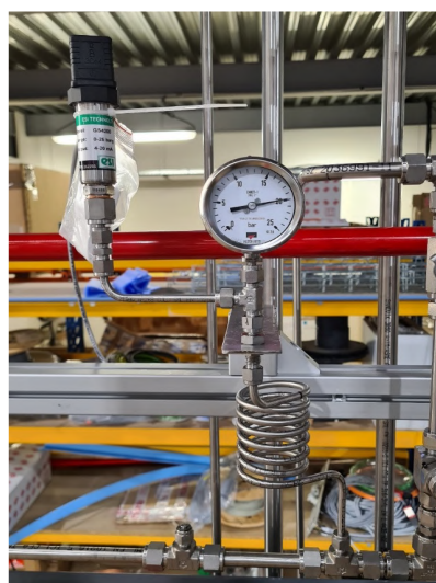
Figura 5.4. Valore di pressione sul manometro utilizzato durante la prova di pressione nel mantello del reattore multitubolare.
