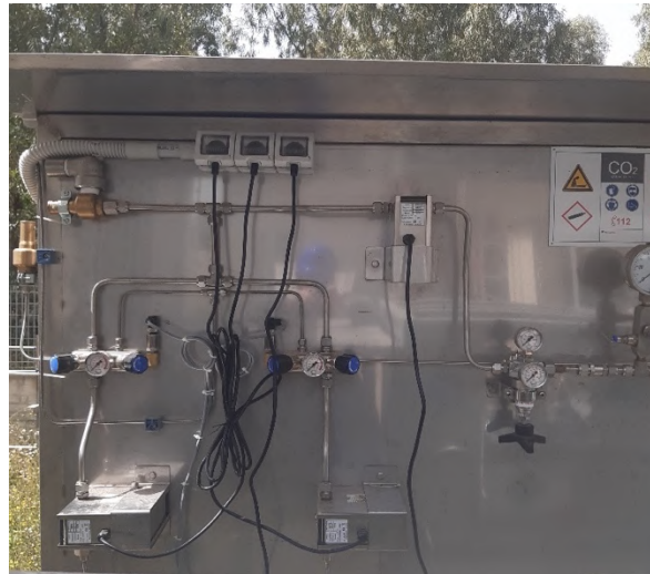
Figura 5.36. Centrale di riduzione della pressione dell'anidride carbonica.
