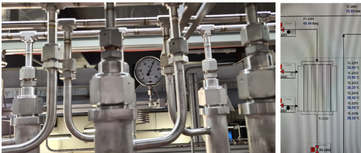
Figura 5.5. Misura di pressione tramite manometro (sinistra) e software di gestione dell'impianto (destra) durante la prova di pressione nel reattore multitubolare (lato processo).
