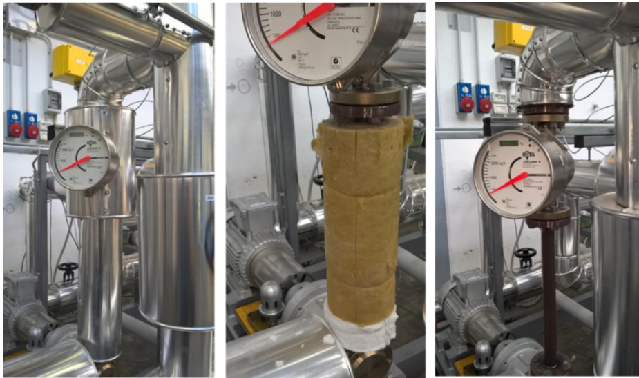
Figura 2-3: Smontaggio vecchio misuratore di portata.
