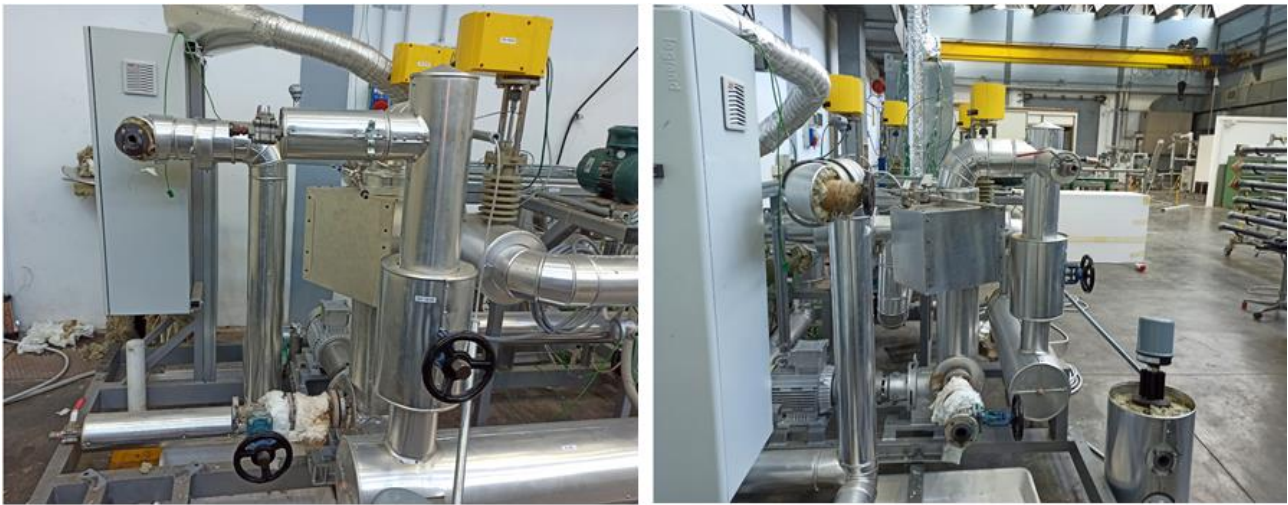
Figura 2-13: particolari che mostrano lo smontaggio del serbatoio precedentemente installato su Solteca3.
