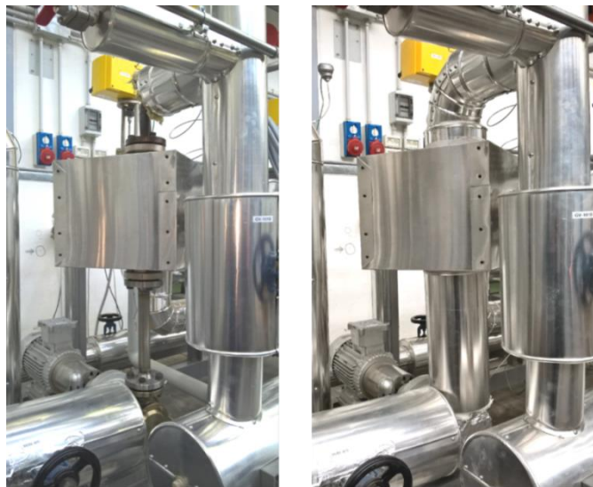
Figura 2-4: Montaggio nuovo misuratore di portata.
