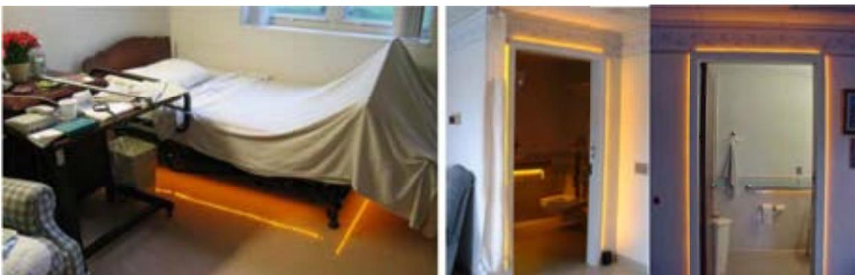
**Figura 15 - Sistema di illuminazione customizzato a LED ambra per il letto e per la cornice del bagno**
