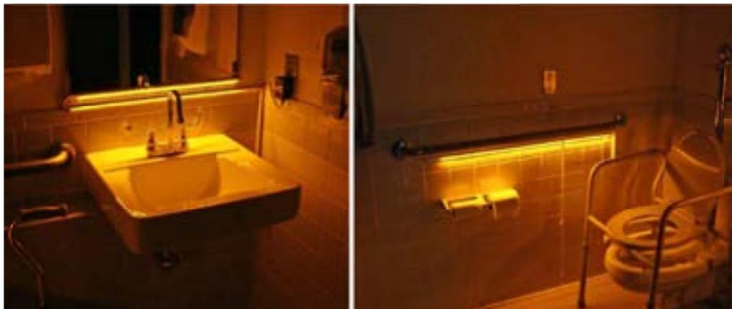
**Figura 16 - Sistema di illuminazione ambra installato all'interno del bagno**
