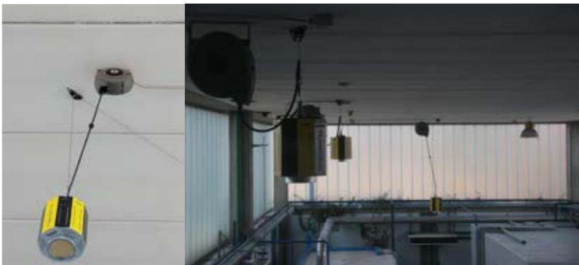
Figura 23: Installazione di carrucole per la movimentazione degli apparecchi
