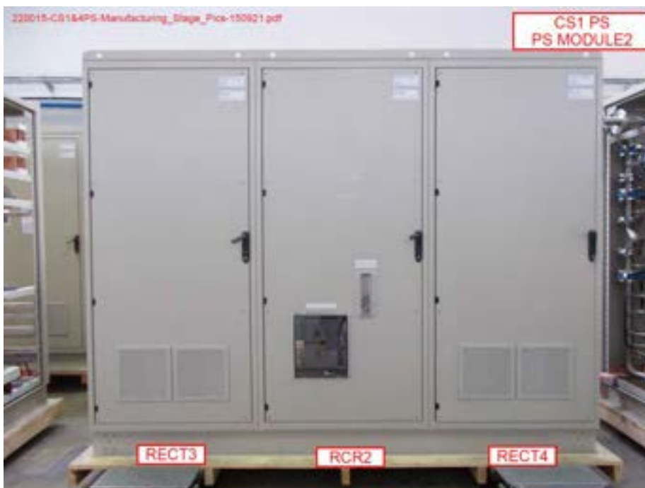
Figura 9 - Realizzazione del modulo 2 del CS1
