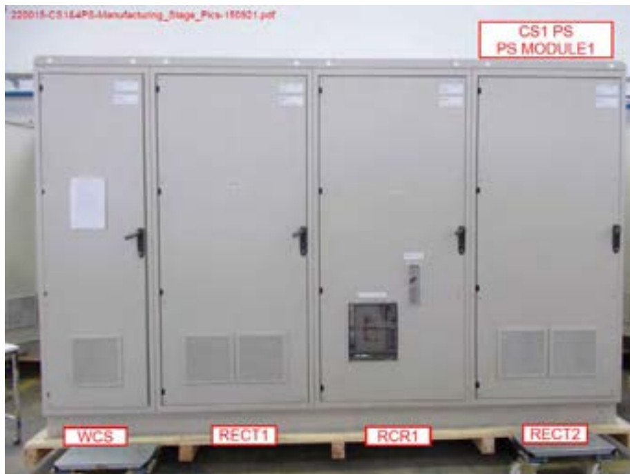
Figura 8 - Realizzazione del modulo 1 del CS1.
