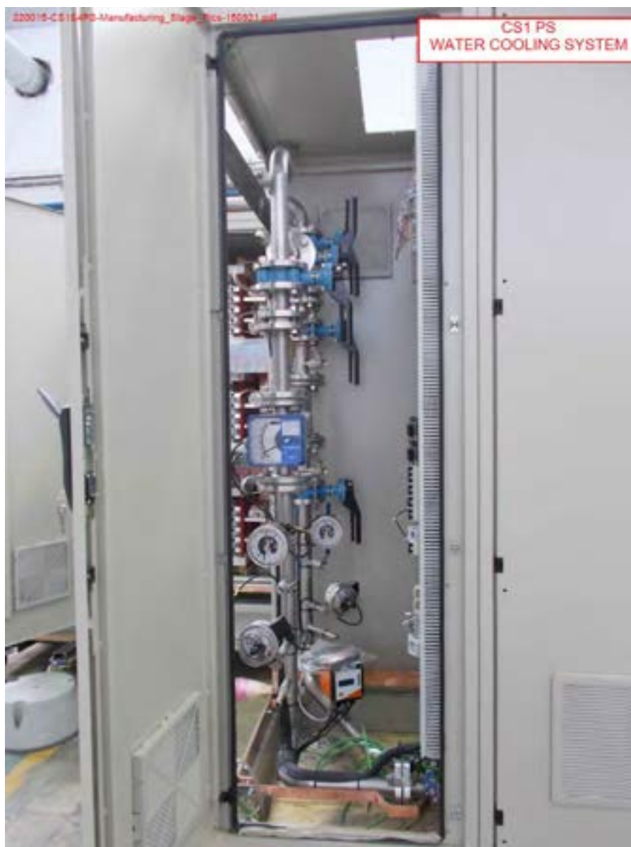
Figura 10 - Sistema di raffreddamento del CS1.
