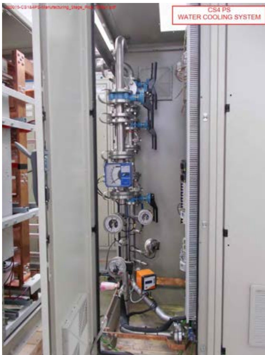
Figura 13 - Sistema di raffreddamento del CS4
