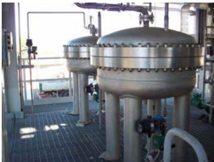
Figura 10 Reattori di assorbimento dell'anidride carbonica.
