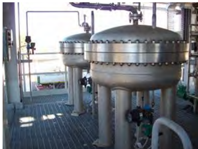
Figura 5-3 Reattori di assorbimento dell'anidride carbonica.
