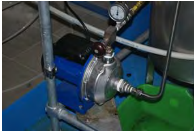
Figura 15-9 Sistema di rilancio del solvente in colonna.
