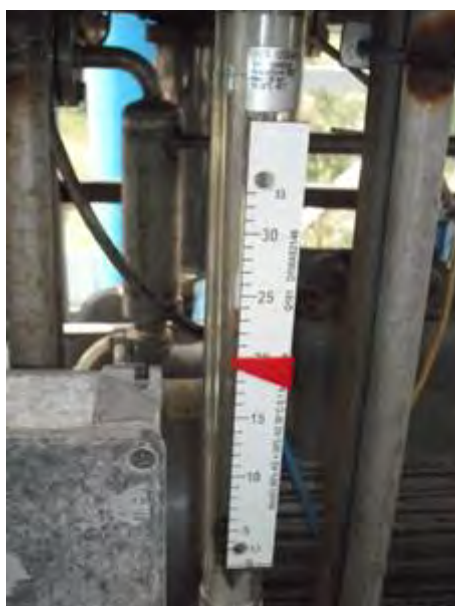
Figura 2.17 - rotametro posizionato fra i due stadi del compressore
