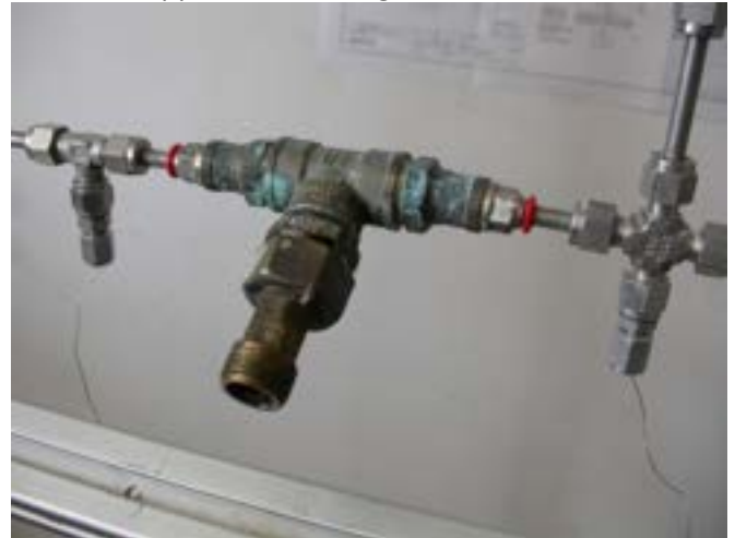
Figura 21collettore privo di coibentazione
