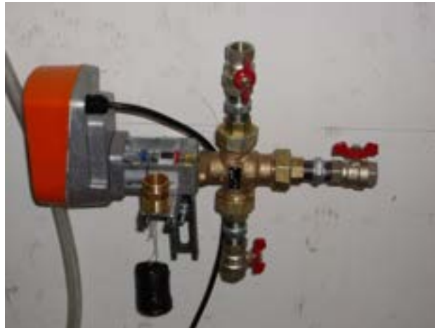
Fig. 17 - Valvola deviatrica e miscelatrice BELIMO
