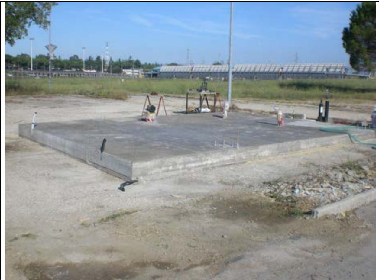
Fig. 8: Basamento centrale termofrigorifera
