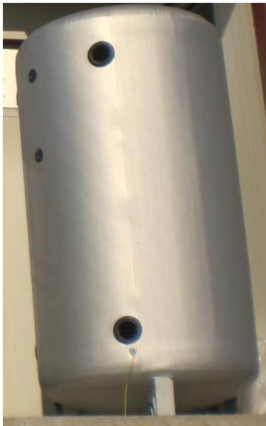
Fig. 20 – Serbatoio inerziale in fase di montaggio
