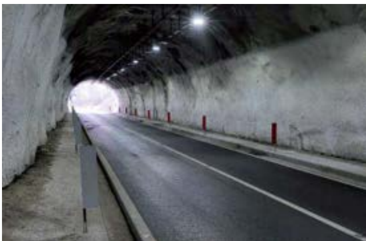
Figura A1.16. La galleria Veilino sulla A12 a Genova, dopo l'intervento.
