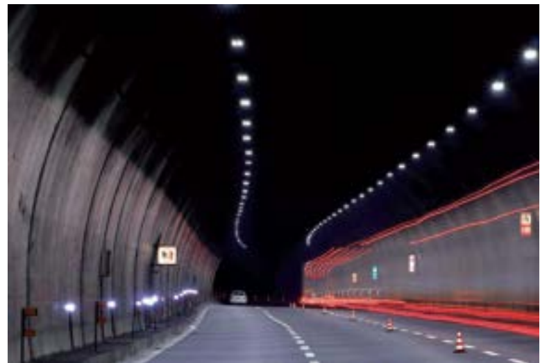
Figura A1.13. La galleria Vado dopo l'intervento.
