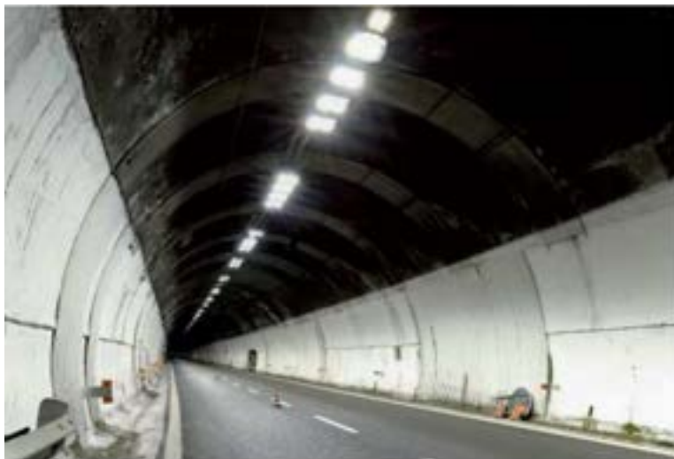
Figura A1.15 La galleria Veilino sulla A12 a Genova, dopo l'intervento.
