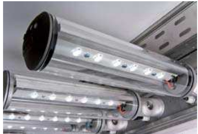
Figura A1.19. L'apparecchio G-LED Tunnel utilizzato per l'illuminazione della Galleria Ortisei.
