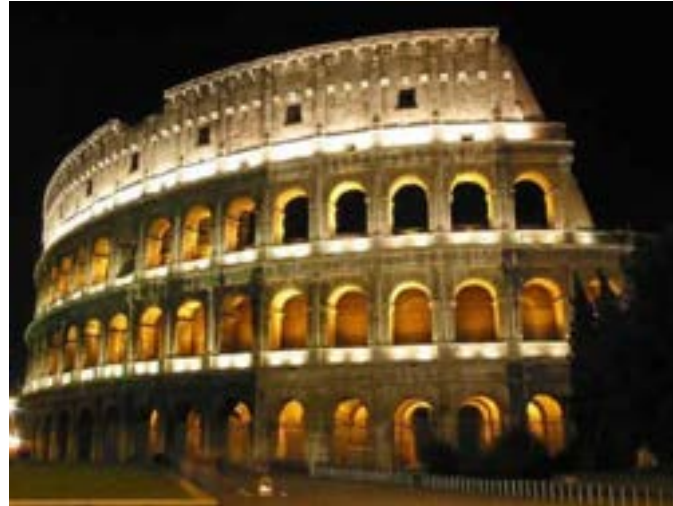
Figura 4.11 - Esempio di illuminazione monumentale, il Colosseo
