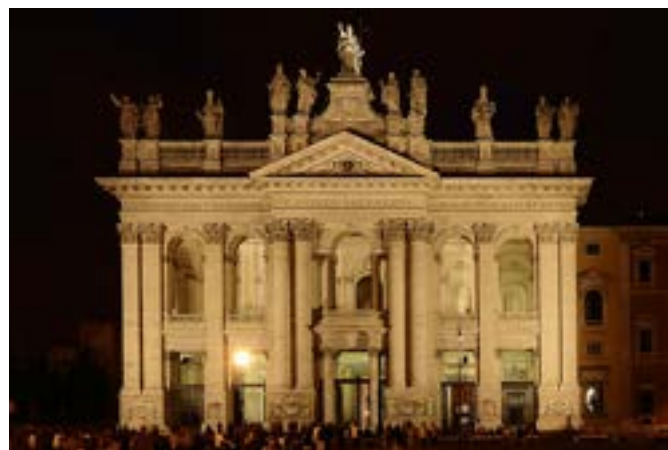
Figura 5.5 Roma - nuova illuminazione della facciata della Basilica di San Giovanni in Laterano
