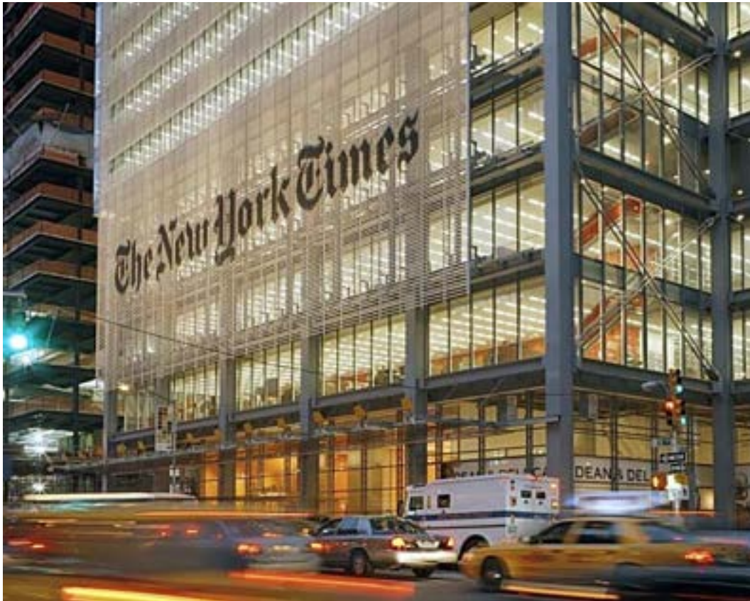
Fig. 2.11 – New York – New York Times Building – una facciata di circa 300 metri, illuminata con sorgenti tradizionali (alogenuri metallici), in questo caso grazie ad un orientamento preciso e alle lampade efficienti si ottiene un tipo di installazione economica e che richiede poca manutenzione (ERCO illuminazione).
