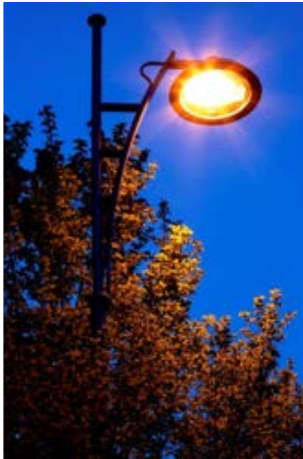
Figura 5.10 Esempio di palo installato a Cernusco sul Naviglio
