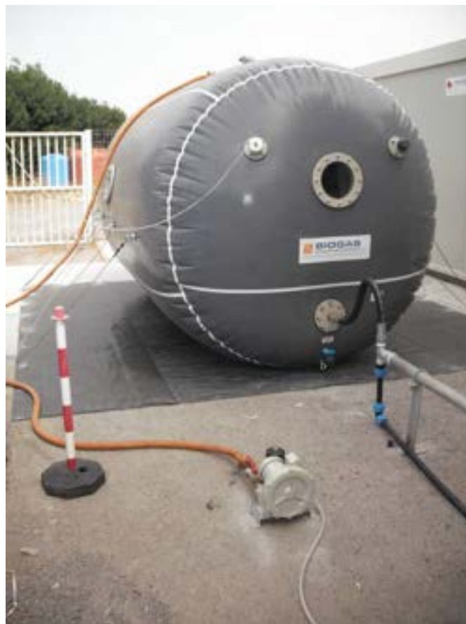
Fig. 2.2 Gasometro nell'impianto pilota
