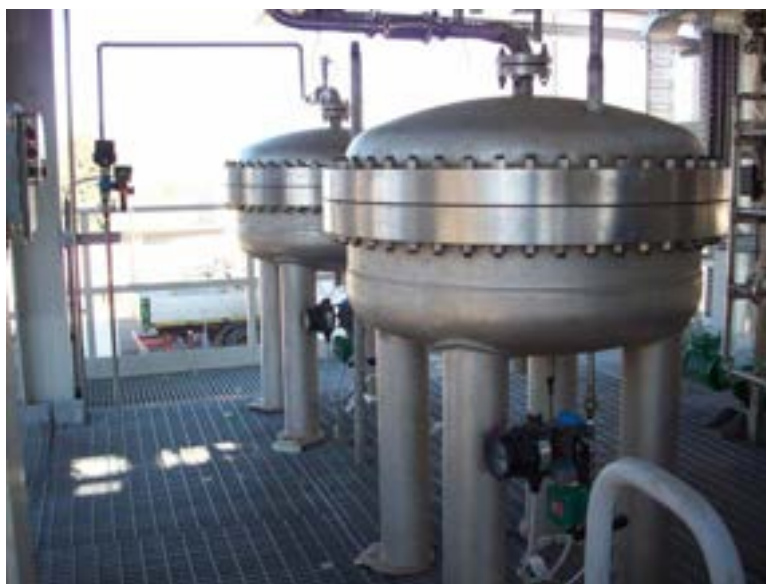
Figura 1.6. Reattori di assorbimento dell'anidride carbonica.
