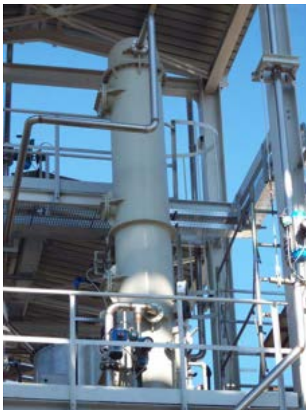
Figura 1.2. Secondo stadio di desolforazione a freddo.
