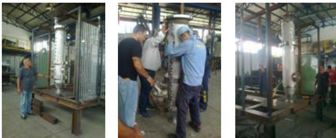
Fig. 10 – Lavori di realizzazione del nuovo impianto GESSICA
