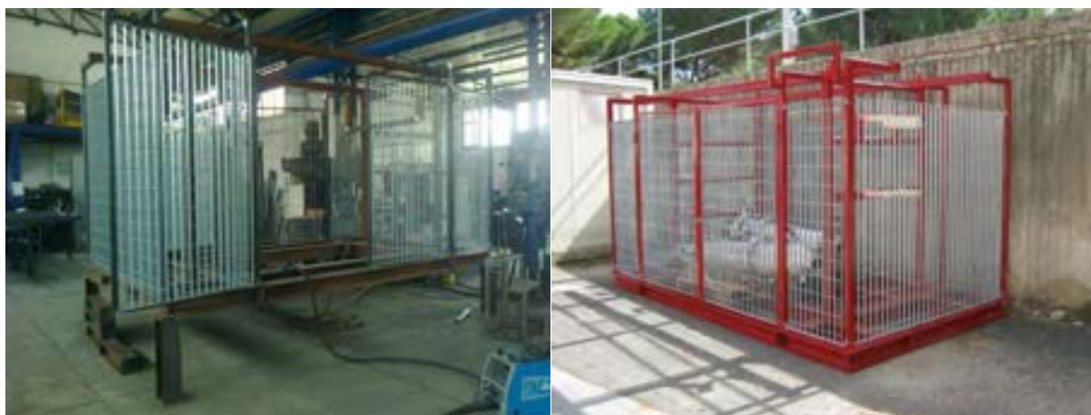
Fig. 11 – Lavori di realizzazione dello skid del nuovo impianto GESSICA
