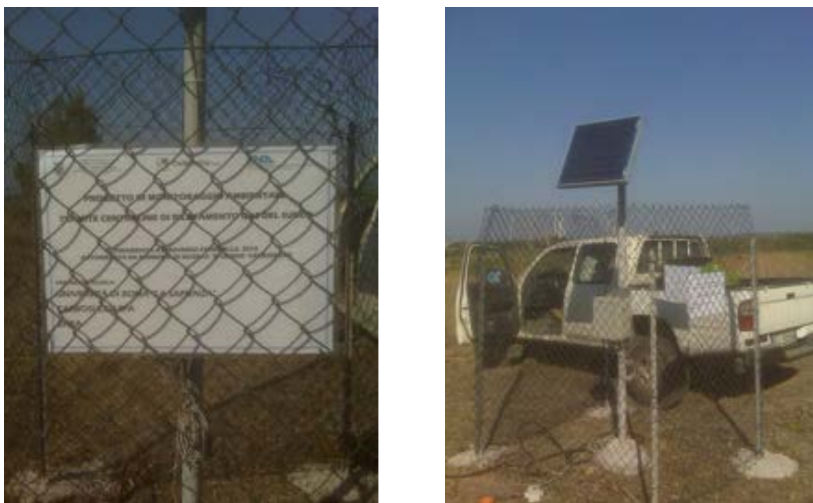
Figura 13. Installazione finale del sistema avvenuta ad agosto 2011.
