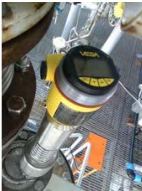
Fig. 15: Vista di dettaglio del misuratore di livello carbone.
