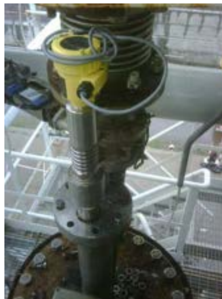
Fig. 15: Vista di dettaglio del misuratore di livello carbone.
