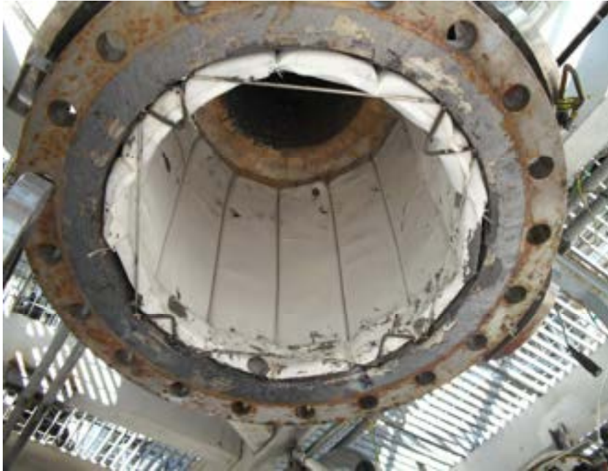
Figura 2.3.4 .fibra isolante interna
