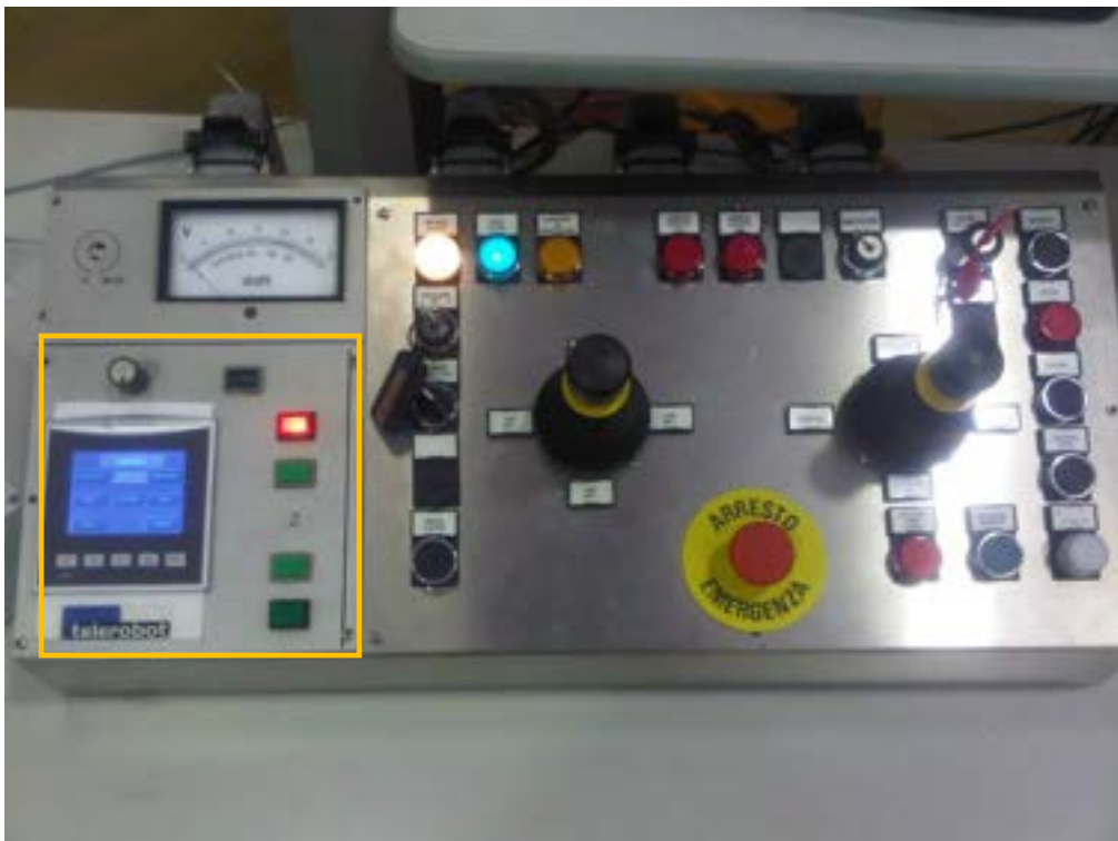
Fig. 13 Modifica pannello locale sala Controllo
