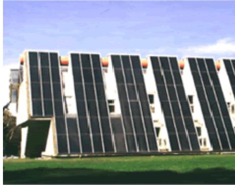
Figura 3. Collettori solari ad aria integrati nella parete sud del corpo A.
