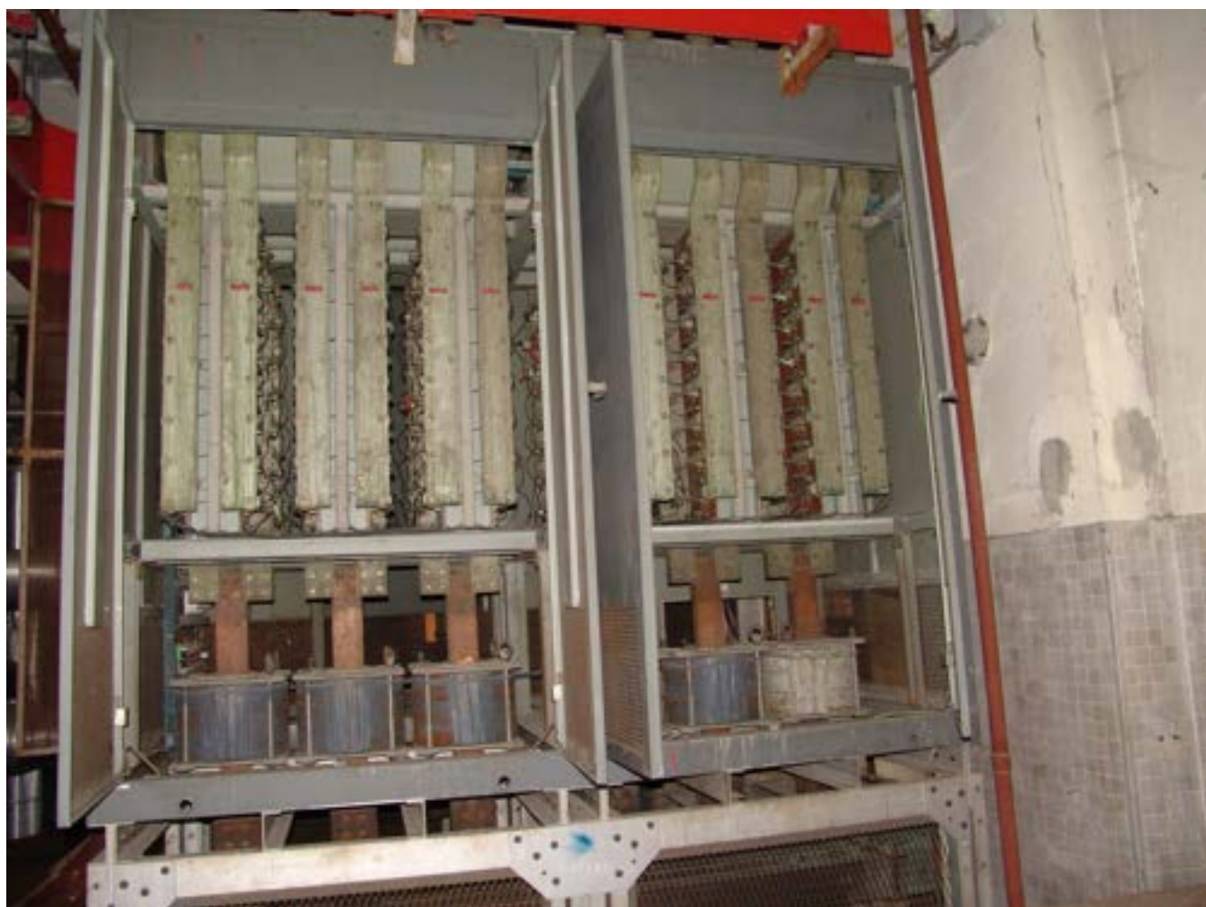
Figura 6 – Gruppo 8 MW C.G.E. zona raddrizzatori
