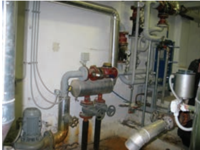
Fig. 41 - Sottocentrale termica
