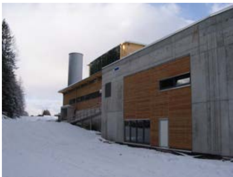
Figura 27 - Immagine della centrale. (Fonte: http://www.fti.bz/it/informazioni/impianto.html ).
