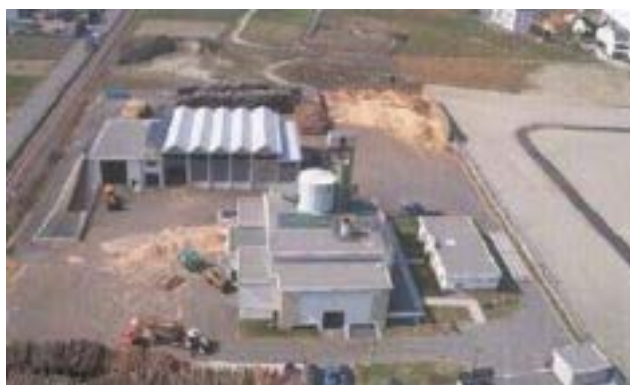
Figura 22 - Impianto a biomasse di Tirano. Fonte: http://www.climatepartner.de/italy/ .
