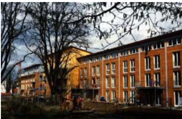
Figura 54 - Immagini del quartiere. (Fonte: http://www.assa-cee.org/asUrban_Vauban.htm ).
