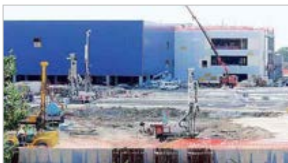
Figura 44 - Immagine del cantiere Ikea – anno 2008. (Fonte: www.gazzettadiparma.it ).
