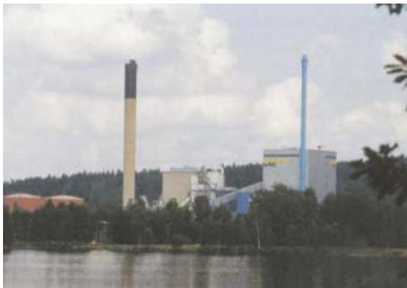
Figura 39 - Vista dell'impianto di cogenerazione Sandvik II.
