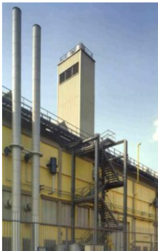
Figura 61. Particolare esterno della centrale di cogenerazione. (Fonte: http://www.aemgas.it/home/cms/aem_gas/impianti/tecnocity/centrale.html ).
