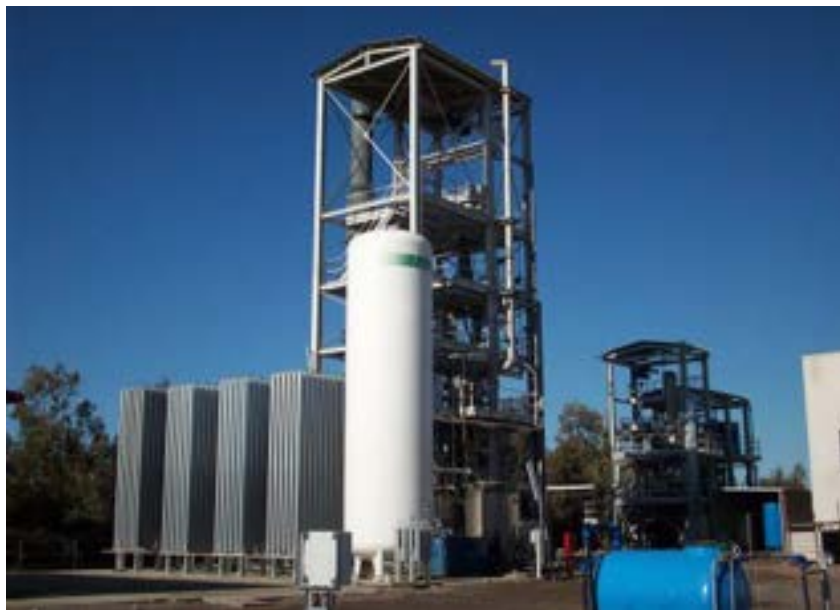
Figura 1.1. La piattaforma pilota Sotacarbo.
