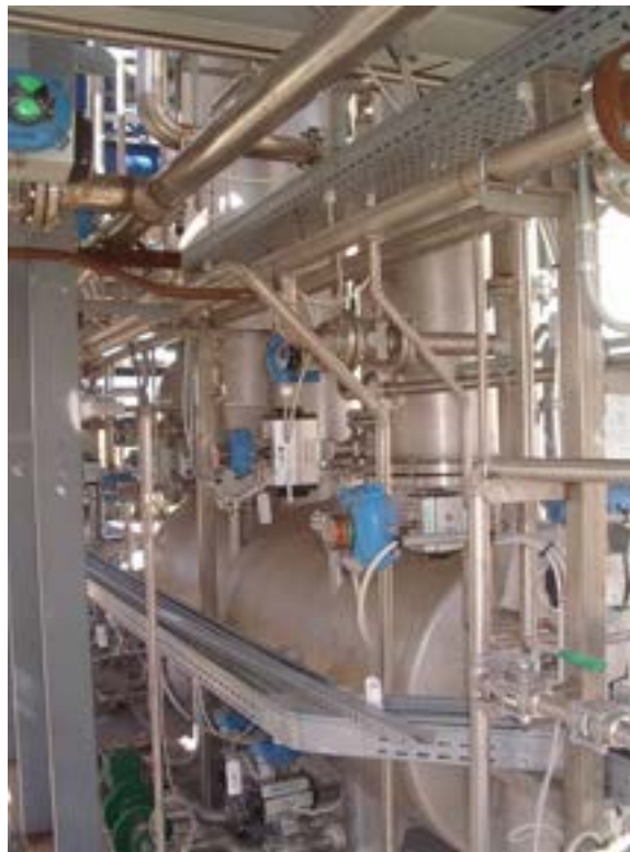
Figura 2.2. Sistema di lavaggio del syngas.
