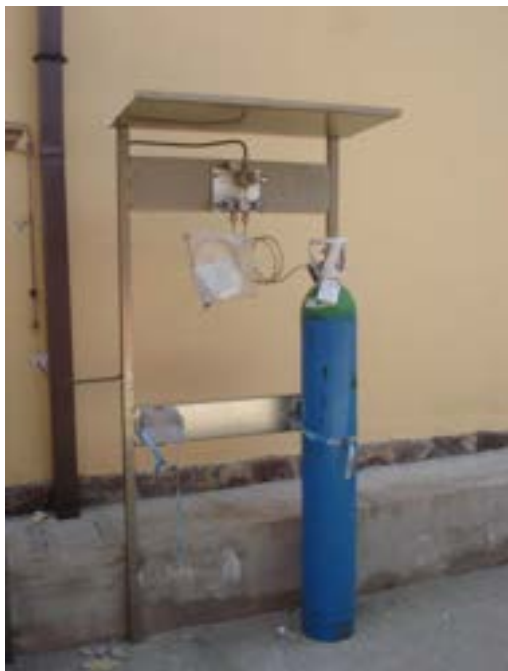
Fig. 7a e fig. 7b – Posto bombola esterno provvisto di riduttore di primo stadio per l'utilizzo di aria destinata al GC 7890 e posto presa dotato di riduttore di secondo stadio per l'utilizzo di elio e aria al GC 7890 alloggiato nel laboratorio di gascromatografia
