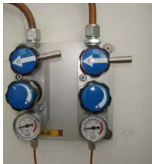
Fig. 7a e fig. 7b – Posto bombola esterno provvisto di riduttore di primo stadio per l'utilizzo di aria destinata al GC 7890 e posto presa dotato di riduttore di secondo stadio per l'utilizzo di elio e aria al GC 7890 alloggiato nel laboratorio di gascromatografia
