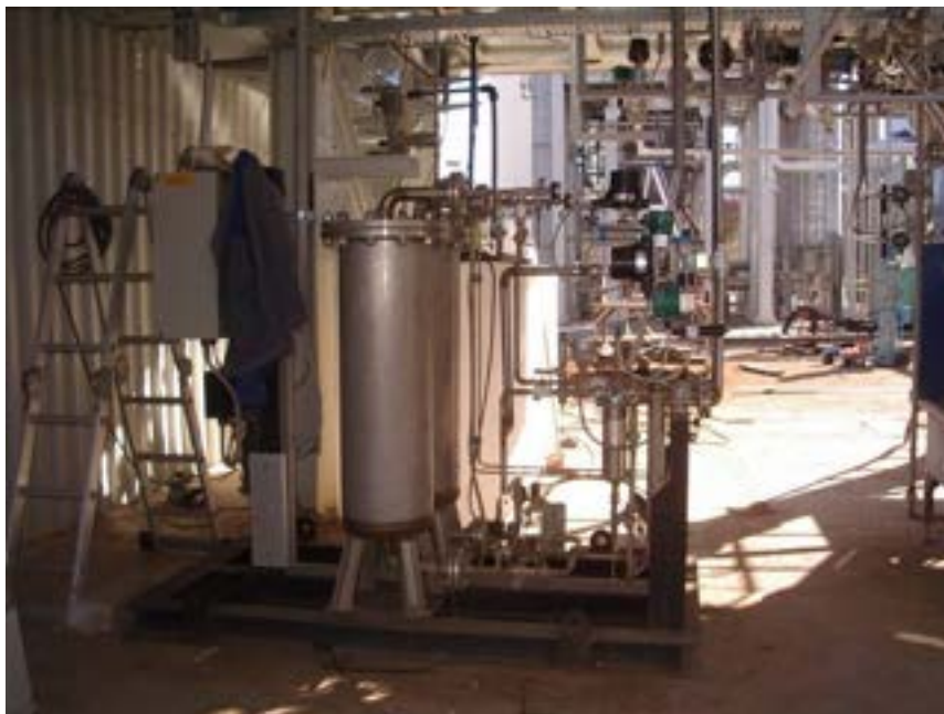
Figura 2.9. Il sistema PSA per la purificazione dell'idrogeno.
