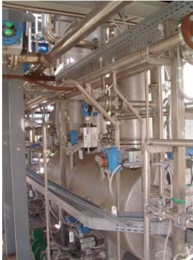
Figura 2.2. Sistema di lavaggio del syngas.
