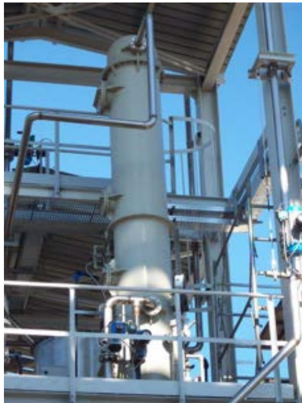
Figura 2.3. Colonna di desolforazione a freddo del syngas.
