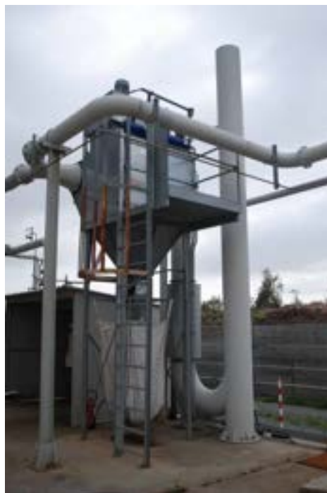
Figura 2.4. Sistema di aspirazione delle polveri.
