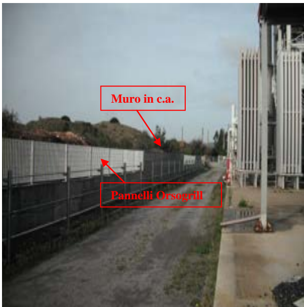
Figura 10 . Recinzione perimetrale impianti
