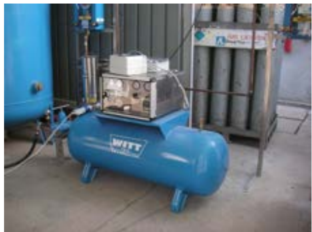
Fig. 16 – Dettaglio miscelatore ossigeno e CO 2
