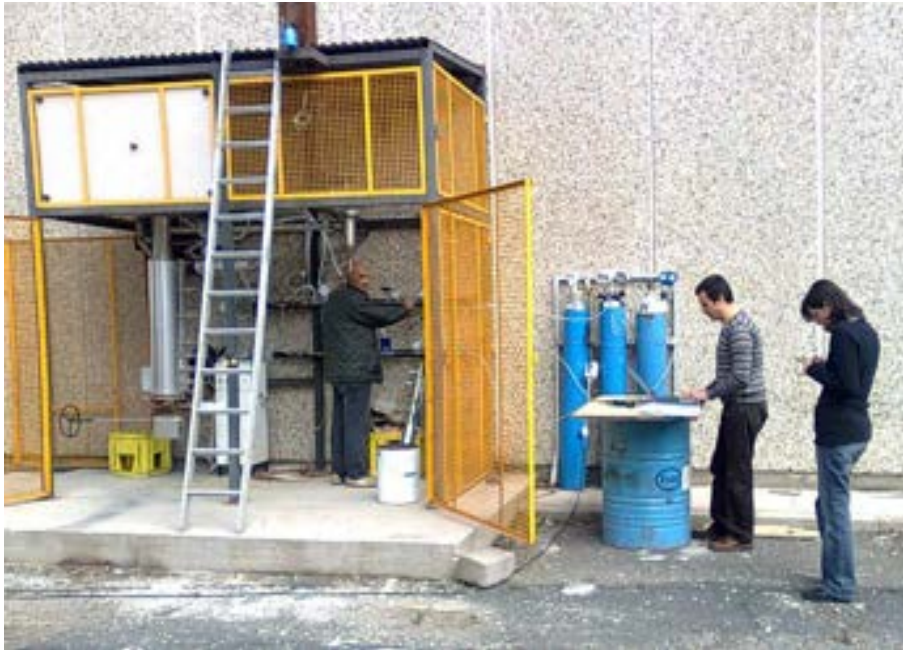
Fig. 6 – Verifiche funzionali sull'impianto
