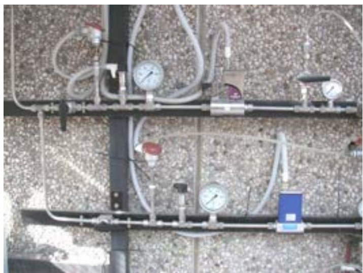
Fig. 6 – Nuove linee di adduzione gas equipaggiate con misura di temperature, pressioni e portate
