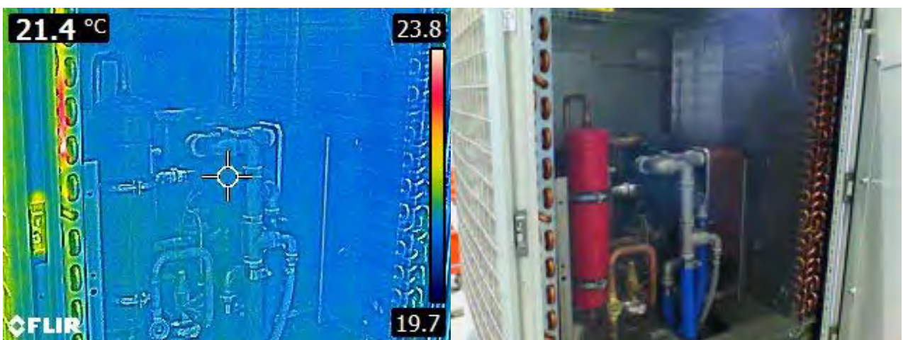
Figura 40: Sistema Sorgente laser e Chiller
