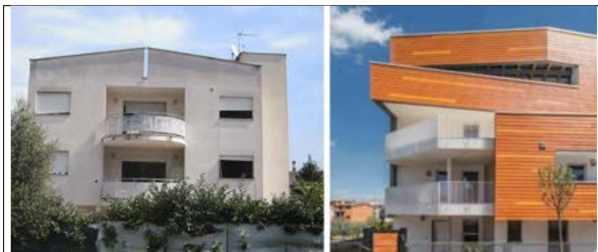
Figura 19 - Edificio residenziale NZEB alla Borghesiana, prima e dopo l'intervento di demolizione e ricostruzione.
