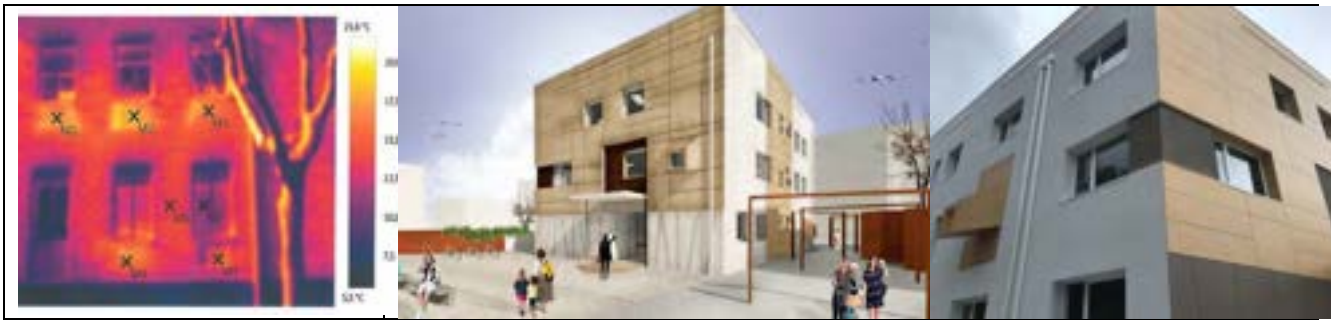
Figura 12 - Municipio di Gabicce Mare: rilievo termografico pre-intervento, progetto e nuova facciata
