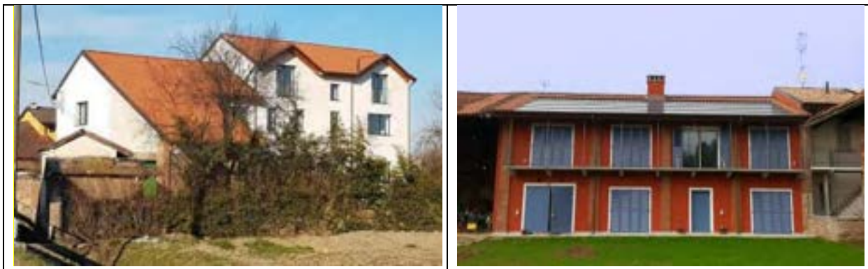
Figura 13 - Ristrutturazioni nZEB a Vespolate e Galliate
