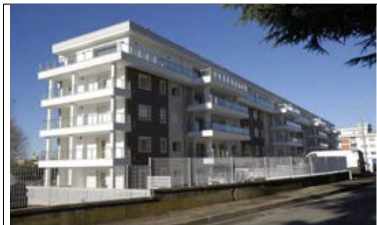
Figura 18 – Edificio residenziale NZEB nuovo nello “Smart Village” a Viterbo
