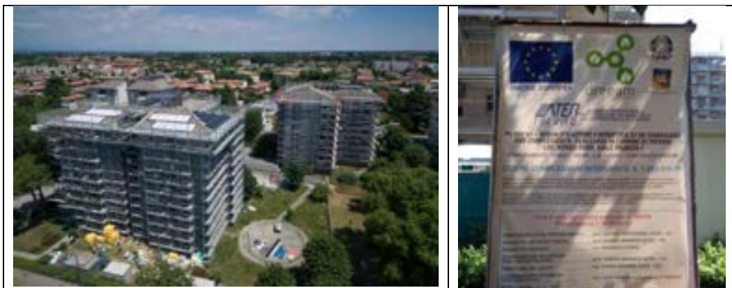
Figura 21 – Ristrutturazione NZEB di ERP di ATER Treviso in via Borgo Furo (TV)
