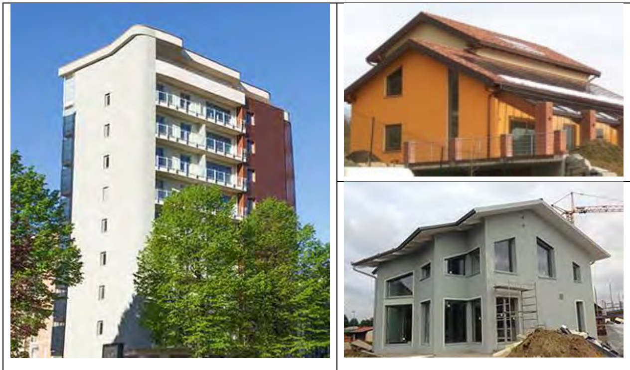
Figura 14. Nuovo edificio condominiale a Torino, edifici residenziali monofamiliare a Lerma (AL, 2013) e Passivhaus a Riva presso Chieri (TO, 2016)
