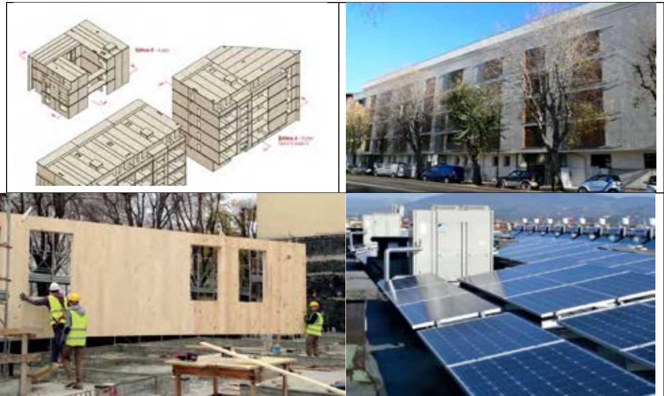
Figura 19. ERP "ex-Longinotti" a Firenze: Edifici NZEB 39+6 alloggi costruiti (con precedente demolizione) mediante tecnologia X-lam. Dettaglio dei pannelli FV e dell'impianto solare termico per l'ACS.
