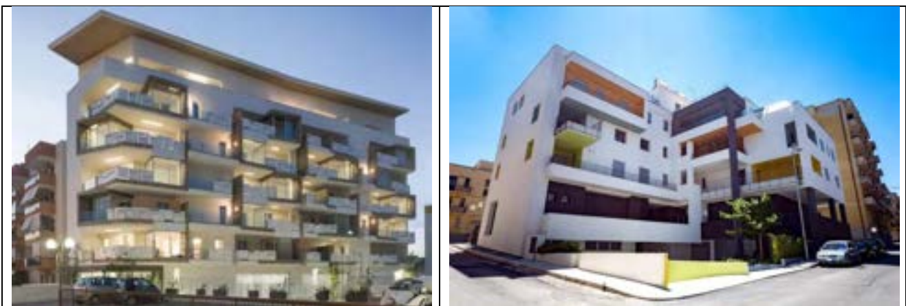
Figura 16. Nuovi edifici residenziali NZEB a Bisceglie e Altamura
