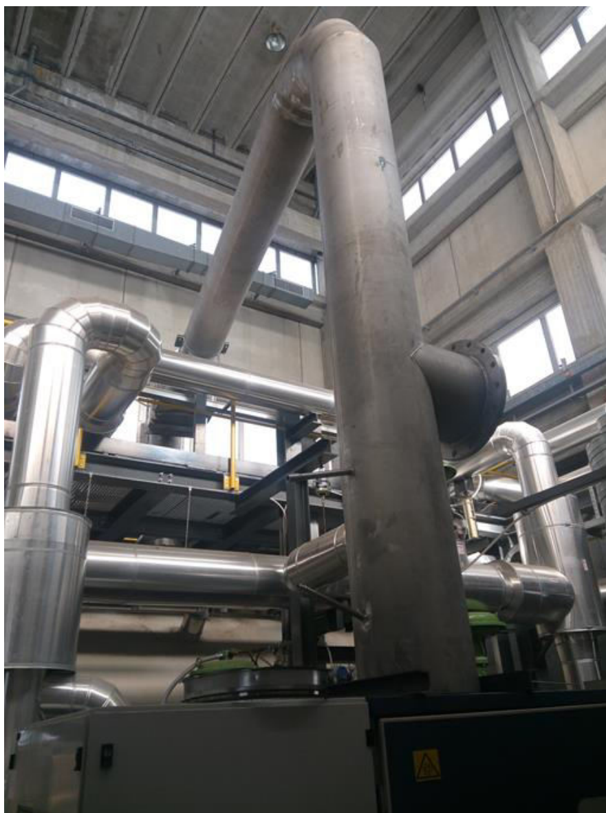
Figura 3 Posa in opera della linea di aspirazione della turbina a gas dell'impianto AGATUR in assetto EGR-emulato.
