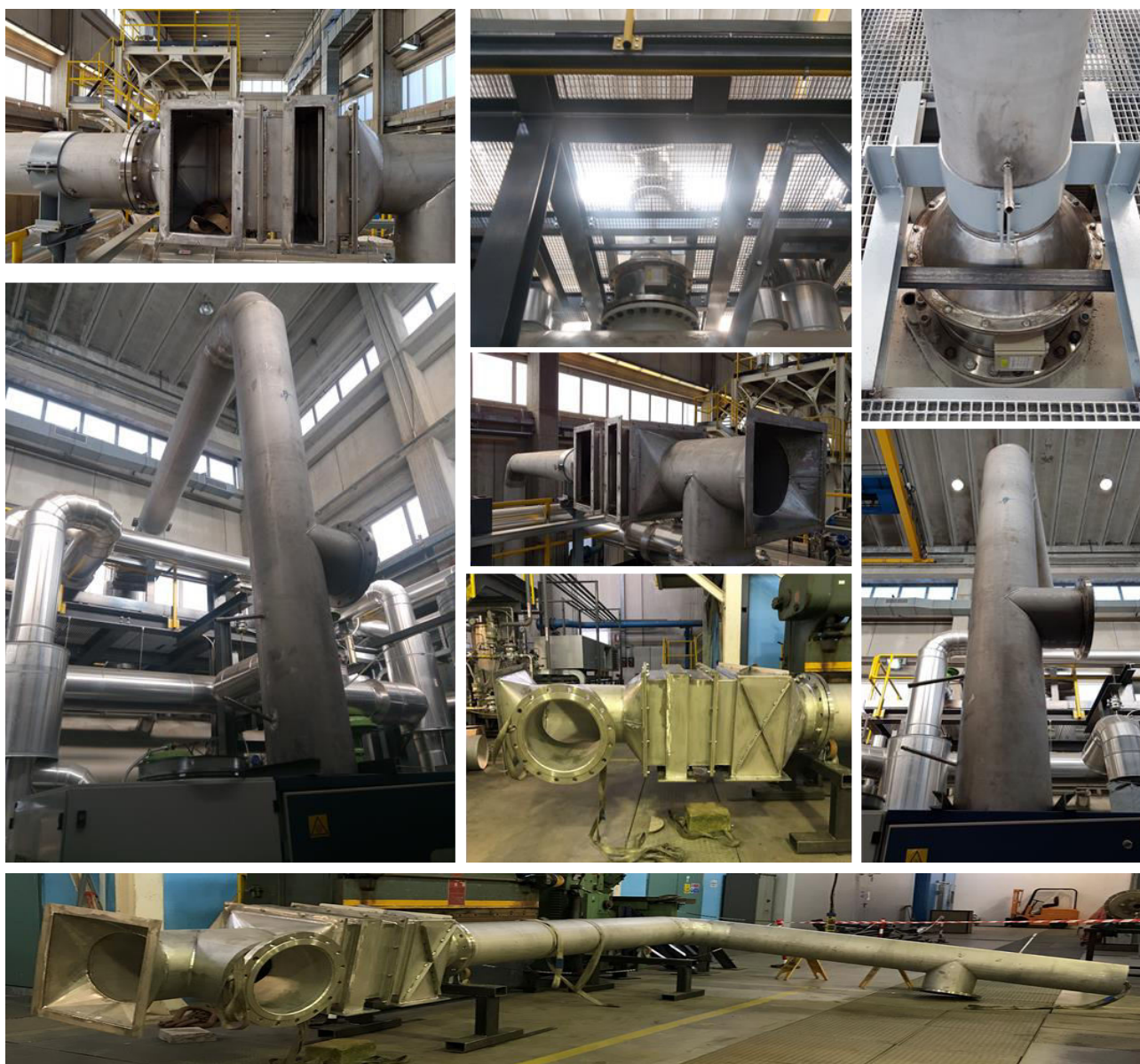
Figura 8. Pre-assemblaggio e posa in opera della linea di aspirazione.
